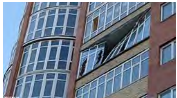
図10 ロシア・チェリャビンスク州に落下した隕石のソニックブームによって被害を受けた建物 11)
